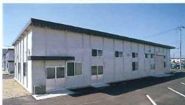
賃貸工場 (5棟) 【100坪タイプ】
