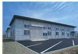
工場棟(3棟)【100坪タイプ】
