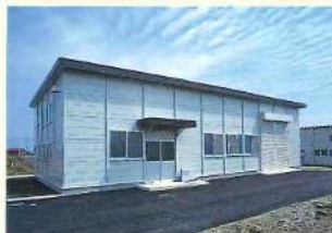
工場棟(7棟)【50坪タイプ】
