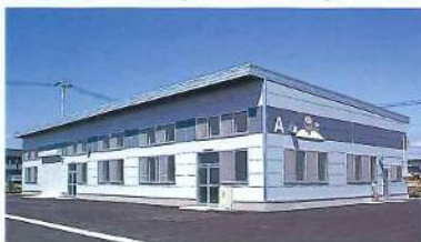
賃貸工場 (4棟) 【150坪タイプ】
