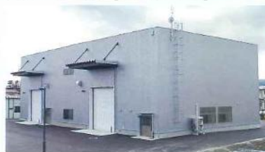
賃貸工場 (1棟) 【180坪タイプ】
